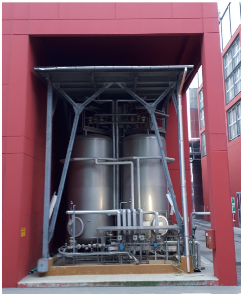
Figura 6 – Serbatoi di stoccaggio soluzione ammoniacale al 24.5%
